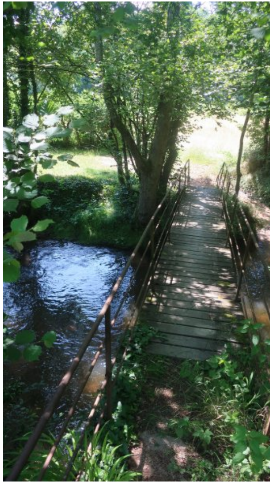
La passerelle sur l'Azergues
